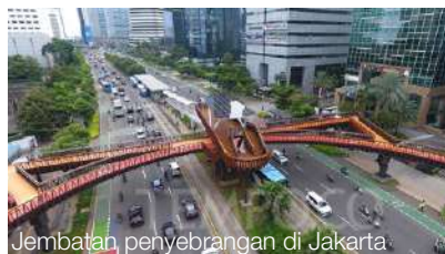
Jembatan penyebrangan di Jakarta
