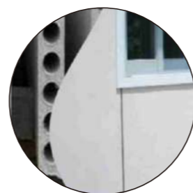
Penggunaan dinding beton pada bangunan agar dapat mengurangi kebisingan yang dihasilkan dari kegiatan praktek
