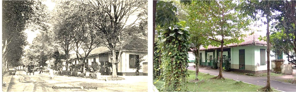
Gambar 5. 2 bangunan rumah dinas kolonial sumber: prakoso,2021
