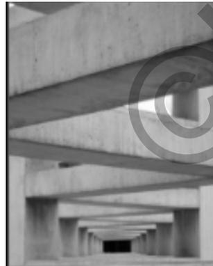
B A L O K MENGGUNAKAN BETON YANG DI EKSPOS.
