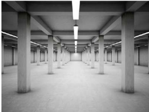
KOLOM MENGGUNAKAN BETON YANG DIEKSPOS.
