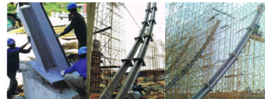
Gambar 110. Pelaksanaan struktur kolom baja
