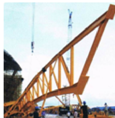
Gambar 114. Ereksi rafter baja
