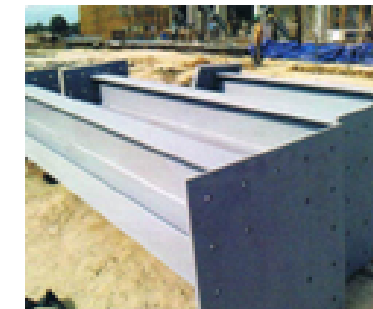
Gambar 112. Kolom Kingcross yang belum terpasang
