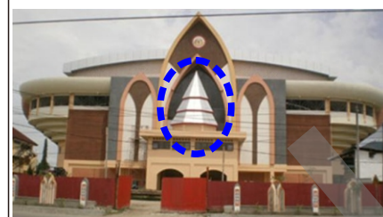
Gedung Olahraga, Jayapura
