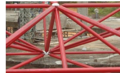
Struktur yang akan dipakai adalah struktur bangunan bentang lebar dengan konsep hi-tech yaitu dengan mengekspose struktur sambungan sbagai bagian dari estetika bangunannya. konsep hi tech ini diaplikasikan pada beberapa ruang yang memang terlibat langsung dengan aktifitas pengunjung.
