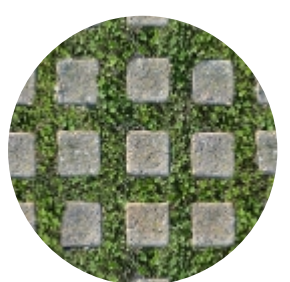
paving pada luar bangunan
