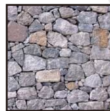
beberapa dinding menggunakan material batu kali sekitar
